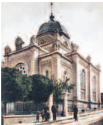
SLIKA 17: Nova sinagoga, srušena 1958.
